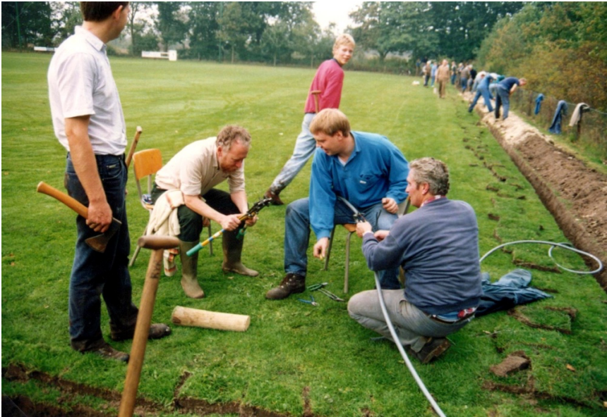
Aanleg elektriciteit naar kantine 'Wintervreugd', 13 oktober 1990.
